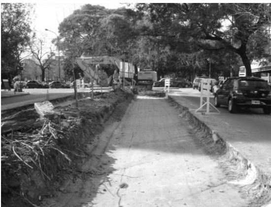
Figura 4: Apertura de caja, retiro de cordones graníticos y corrección de subrasante con cal
