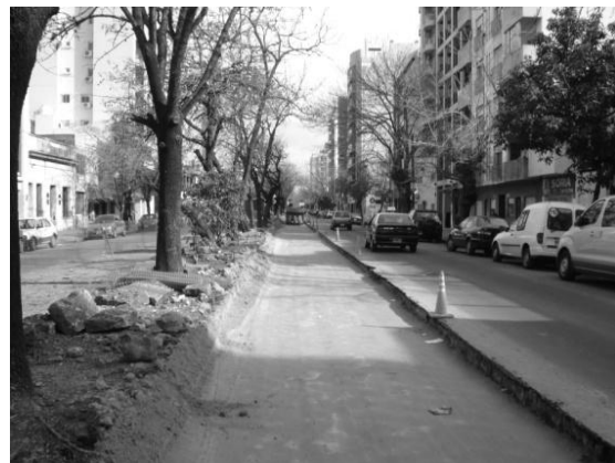
Figura 5: Ejecución de sub base de suelo seleccionado
