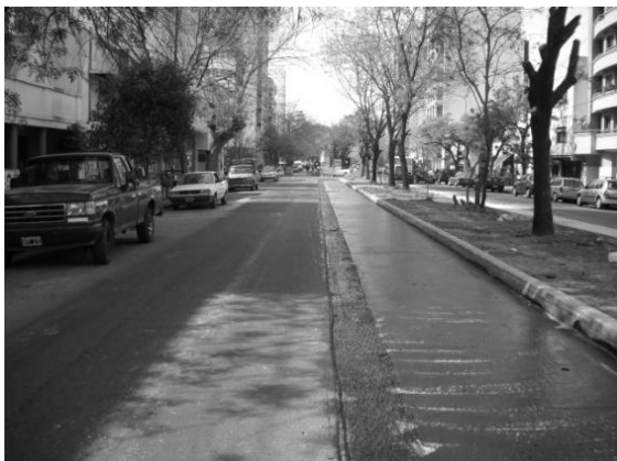
Figura 6: Fresado de carpeta asfáltica existente y aplicación del riego de liga
