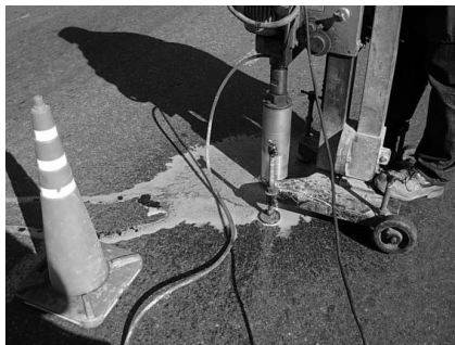
Figura 10: Calado de testigos del pavimento
