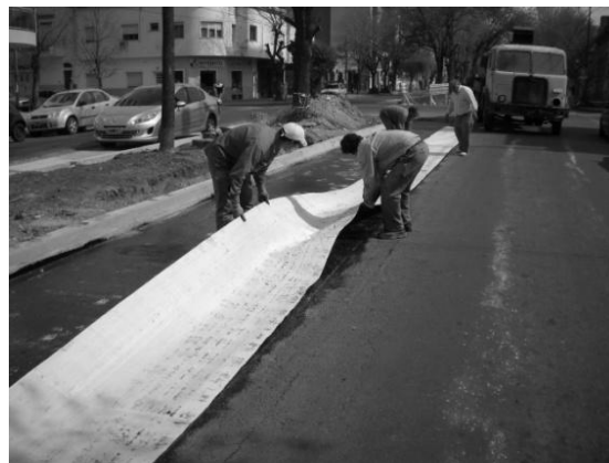
Figura 7: Colocación del producto Geocompuesto
